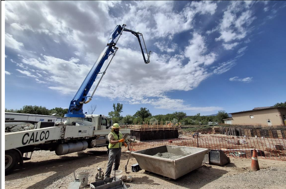
Backwash Tank Wall Pour
